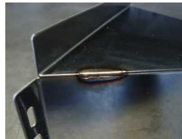
ガス溶接(アルゴンガス使用)による溶接状態
